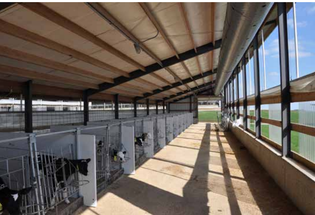
Mekanisk ventileret kalvestald i Wisconsin. Foto: Henrik Læssøe Martin
